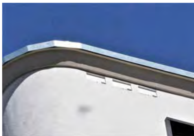
Côté ouest du Silo est
