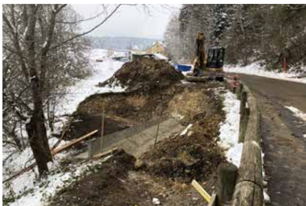
Construction du mur
