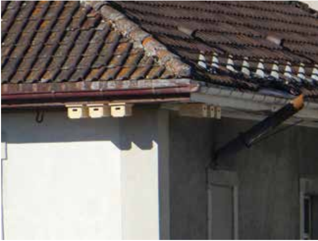
Nichoirs provisoires sur le 3e bâtiment
