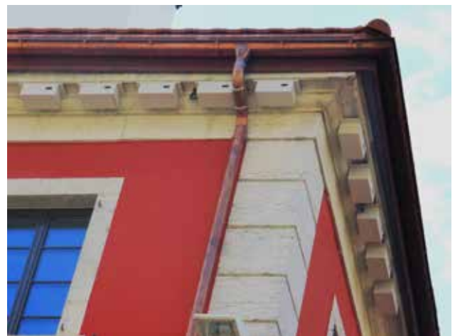
Une partie des nichoirs placés sur les échafaudages du bâtiment de la Place du Marché et leur position définitive en ce mois de mai 2024
